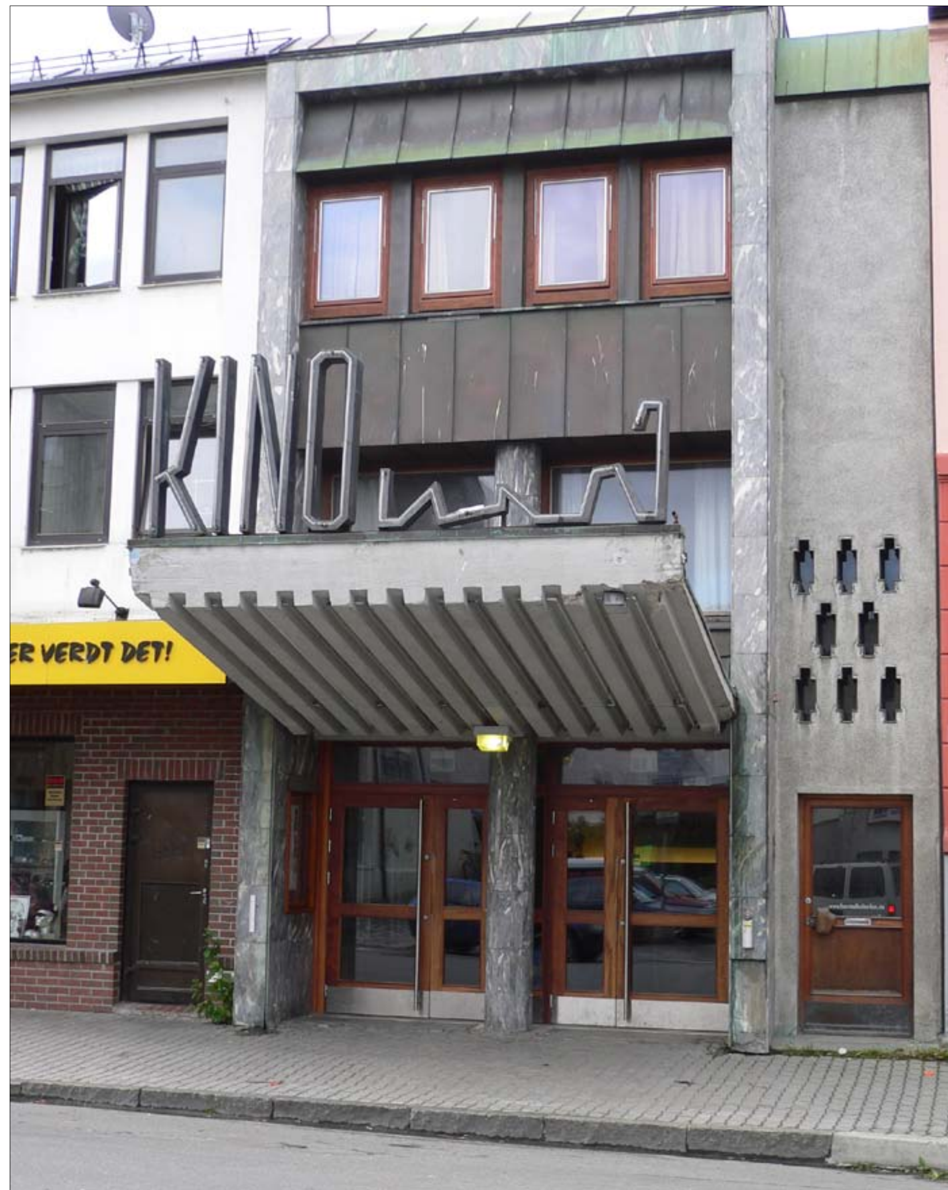
FASADE: Kinoens fasade mot gata måtte tilpasses plassen mellom to eiendommer, men fremhevet seg likevel på en positiv måte. FOTO: GUNNAR REPPEN.
