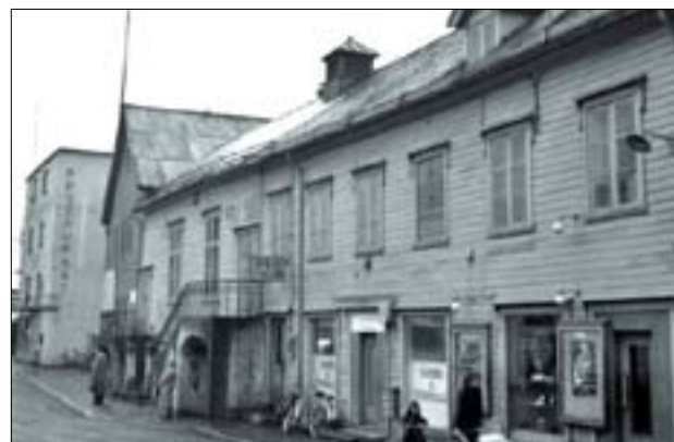
«CENTRALHALLEN»: I 25 år holdt kinoen til i «Centralhallen» i Rikard Kaarbøs gate 3. Gården hadde tidligere vært hotell. FOTO: JOHN BERTHUNG.
